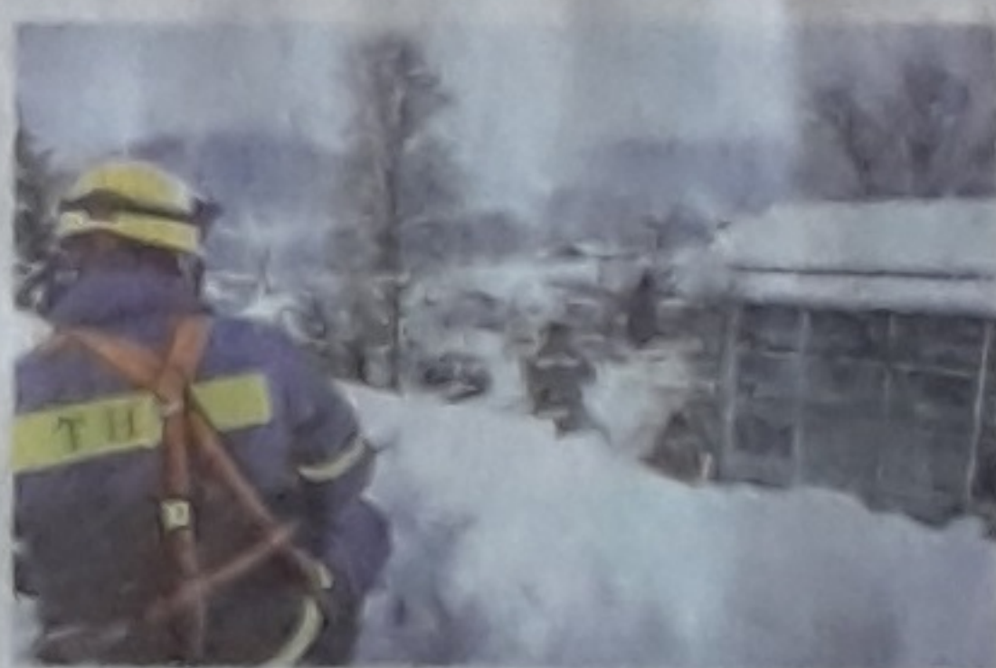
Helfer räumen das Dach einer Klinik in Bad Reichenhall. Foto: THW Bayern
